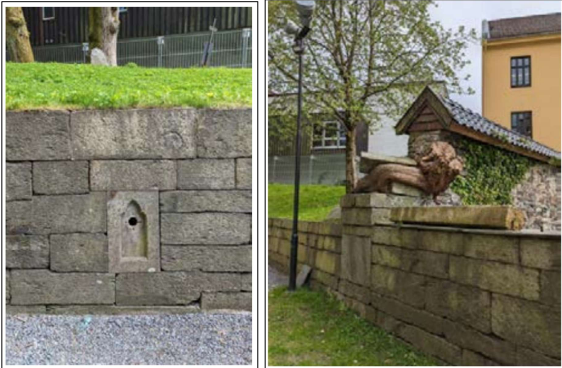
Figur 41: Gravområdene rundt kirken er støttet opp av en kvadersteinsmur. På foto til venstre synes en vannpost. Dette kan være en videreføring av vannposten som ble etablert i 1860, som i dag ikke er i bruk (Foto: Byantikvaren, 2025).
