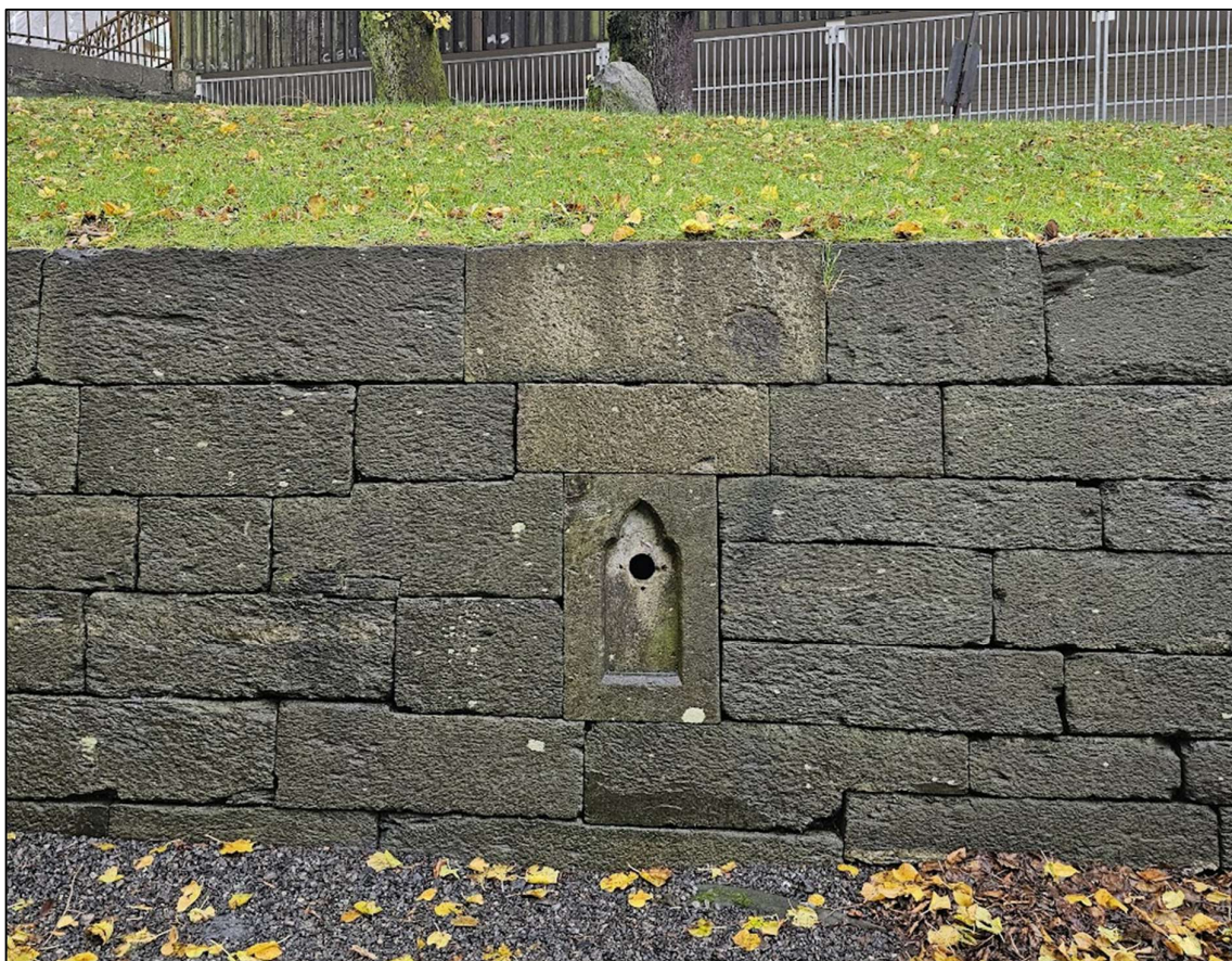
Figur 14: Foto av tidligere vannpost i mur fra tiden etter at terrenget bak kirken ble senket med opp til 2,4 meter (1880-83). Dette kan være en ombygging av vannposten som ble etablert i 1860 (Foto: Byantikvaren, 2025).
