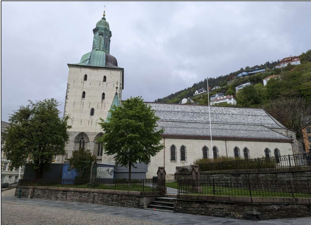
Figur 44: Mur og jernstakitt langs Kong Oscars gate. Gjerdet er festet i granittblokker plassert på skiferheller over murene (Foto: Byantikvaren, 2023).
