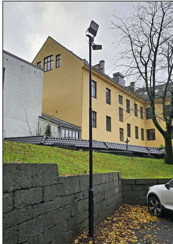
Figur 48: Eksempel på stolpe med fasadebelysning, som står rundt koret (Foto: Byantikvaren, 2025).
