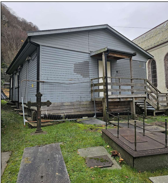
Figur 24: Midlertidig anleggsbrakke etablert i forbindelse med istandsettingen av middelalderkirkene i sentrum (Foto: Byantikvaren, 2025).
