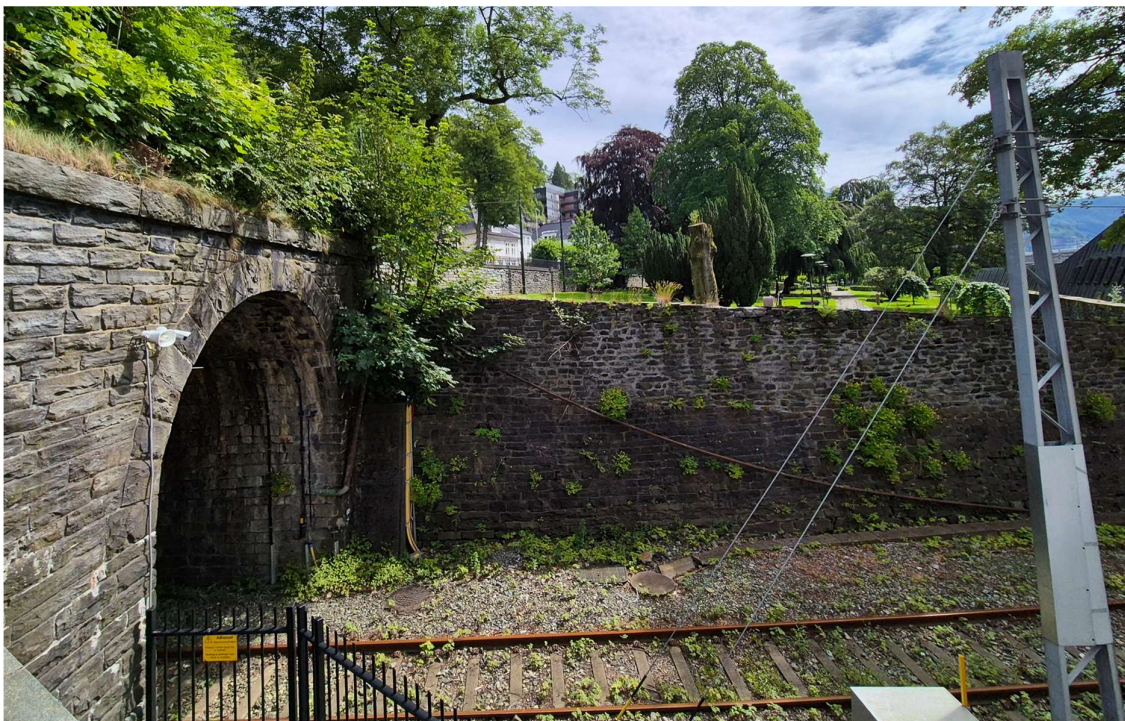
Figur 39. I 1917 førte byggingen av en jernbaneforbindelse til havnen ved Bergenhus til at store deler av gravplassen i nordvest ble fjernet. Bildet viser tunnelåpningen og støttmurene mot Assistentkirkegården (Foto: Byantikvaren 2024).
