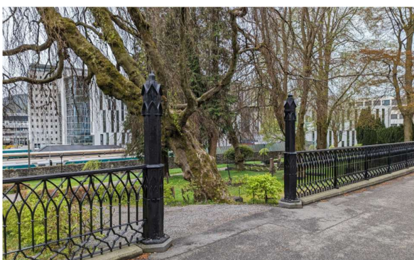
Figur 35. Hovedinngang til gravplassen og svartlakkerte metallgjerder langs Kalfarveien (Foto: Byantikvaren 2024).
